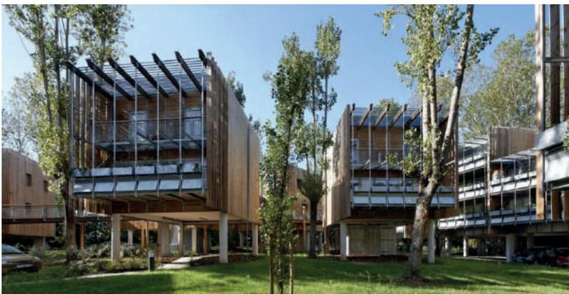
Les pilots permettent de s'affranchir de la pente et de dégager un volume pouvant être utilisé pour masquer le stationnement. Il pourra s'agir de parking semi aérien si une partie du bâtiment est adossé au terrain.
